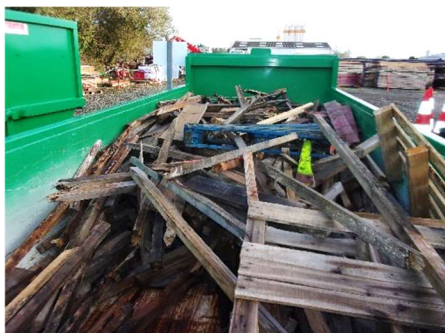
Figure 35 : benne de déchets de bois issus de travaux du BTP
