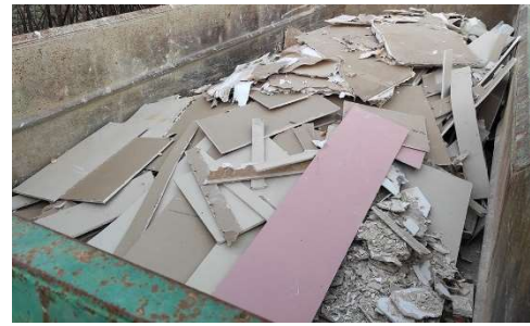
Figure 33 : benne de déchets de plâtre recyclables
